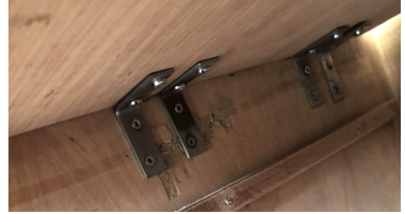
Abbildung 15: Die an der Zwischenwand und Sitzplatte befestigten Winkel (eigene Aufnahme)
