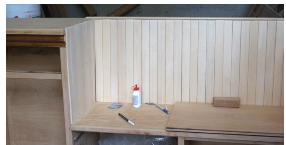
Abbildung 18: Alle Lättchen sind angebracht, (eigene Aufnahme)
